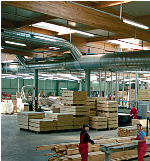
Εικόνα 5. Δίκτυο αεραγωγών και κυλιόμενα απορροφητικά για την απαγωγή της σκόνης ξύλου.
