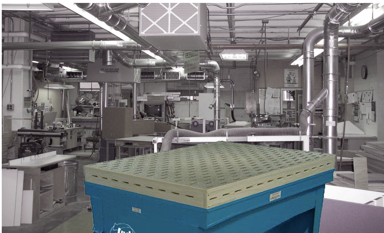
Εικόνα 7. Σύστημα απαγωγής σκόνης ξύλου με απορρόφηση αέρα μέσω οπών στον πάγκο εργασίας των τριβείων.
