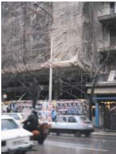
◀ Περίφραξη - Άδεια κατάληψης πεζοδρομίου από το Δήμο - Σκαλωσιά με κάλυψη και προστατευτικό προστέγασμα.
