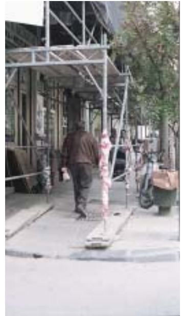
◀ Ασφαλής διέλευση κάτω από τη σκαλωσιά. Απαιτείται νυχτερινός φωτισμός. ▶
