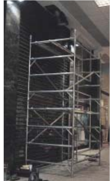
▲ Κινητή σκαλωσιά με ασφαλείς διαστάσεις. Απαιτείται: πλήρες δάπεδο εργασίας-προστασία έναντι πτώσης, σκάλα προσδεμένη για ανάβαση.
