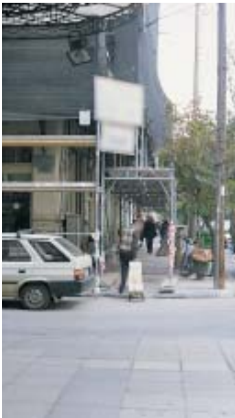
◀ Ασφαλής διέλευση κάτω από τη σκαλωσιά. Απαιτείται νυχτερινός φωτισμός. ▶
