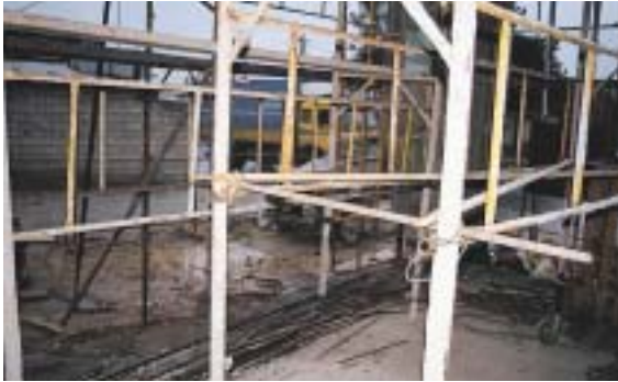
▲ Απαράδεκτη σύνδεση ακατάλληλων στοιχείων (υπολείμματα υλικών) σε σκαλωσιά.
