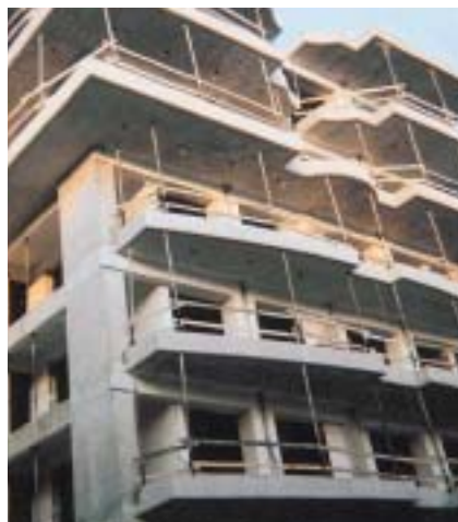
Ασφαλής προστασία στα πέρατα των εξωστών με πατοκοιλώνες και οικοδομικό πλέγμα/ σανίδια.
