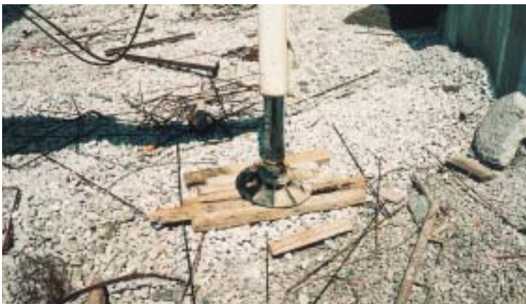
▲ Λανθασμένη έδραση ποδαρικού. Κίνδυνος ανατροπής της αντλίας. Απαιτείται έδραση σε τάκους, αφού καθαριστεί το έδαφος από τα χαλίκια. >
