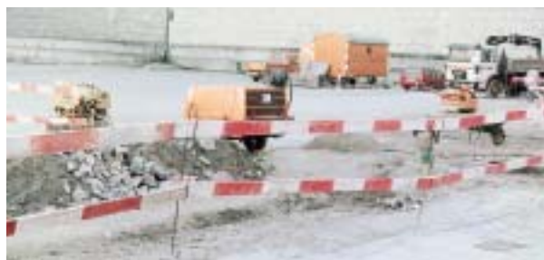
▲ Ασφαλής περίφραξη τμήματος εργοταξίου.
