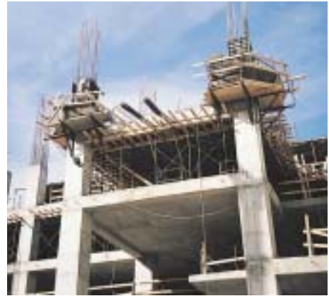
Ασφαλείς σκαλωσιές εξωτερικών τοιχείων και στύλων.
