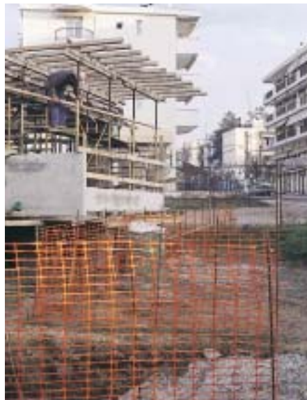
Καλή προστασία πέρατος πλάκας και εσωτερική περίφραξη στα άκρα εκσκαφής.
