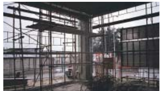
▲ Κινητή σκαλωσιά (πύργος) ανασφαλής. • Ύψος > του 3πλάσιου της μικρότερης πλευράς της βάσης. Κίνδυνος ανατροπής. • Δεν υπάρχει σκάλα για ασφαλή ανάβαση - κατάβαση. • Δεν έχει ολοκληρωμένη προστασία έναντι πτώσης.
