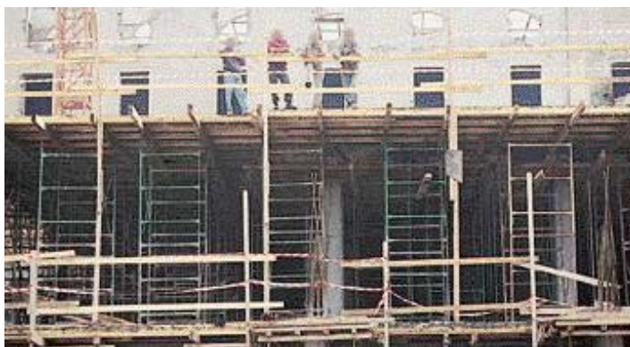
Ασφαλής προστασία και σήμανση στα πέρατα ξυλότυπου.
