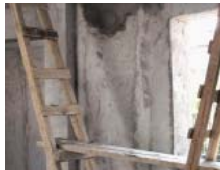
Λανθασμένη και ανασφαλής χρήση φορητών κλιμάκων για έδραση δαπέδων εργασίας.
