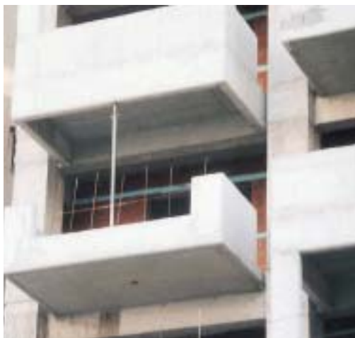
Ασφαλής προστασία στα πέρατα των εξωστών με πατοκοιλώνες και οικοδομικό πλέγμα/ σανίδια.
