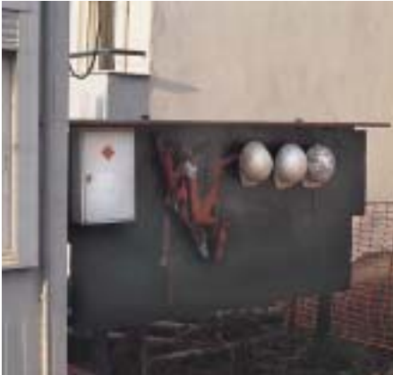
▲ Φαρμακείο και Μ.Α.Π. σε ευκρινή θέση στο εργοτάξιο.
