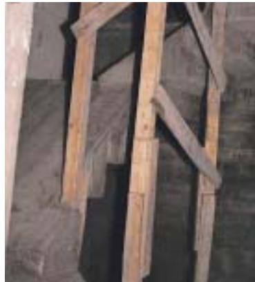
Καλή προστασία στο φανάρι (κου- βάς) κλιμακοστασίου.
