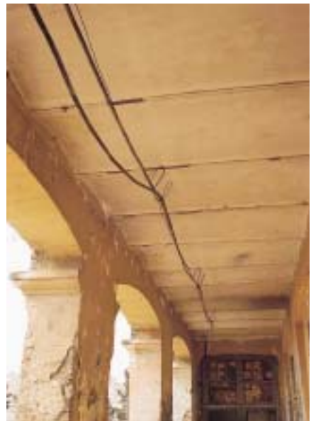
Ασφαλής ανάρτηση καλωδίων.
