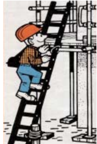
▲ Ασφαλής χρήση φορτιής σκάλας.
