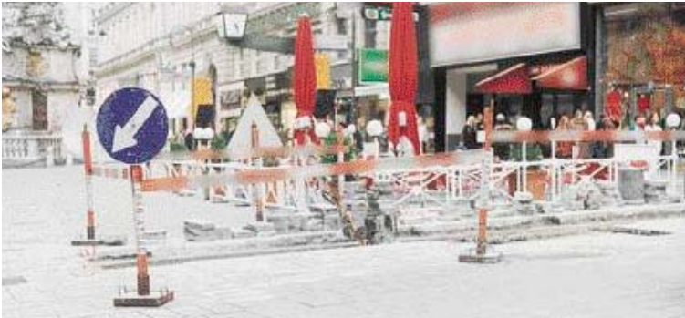
Ασφαλής περίφραξη και σήμανση εργοταξίου.
