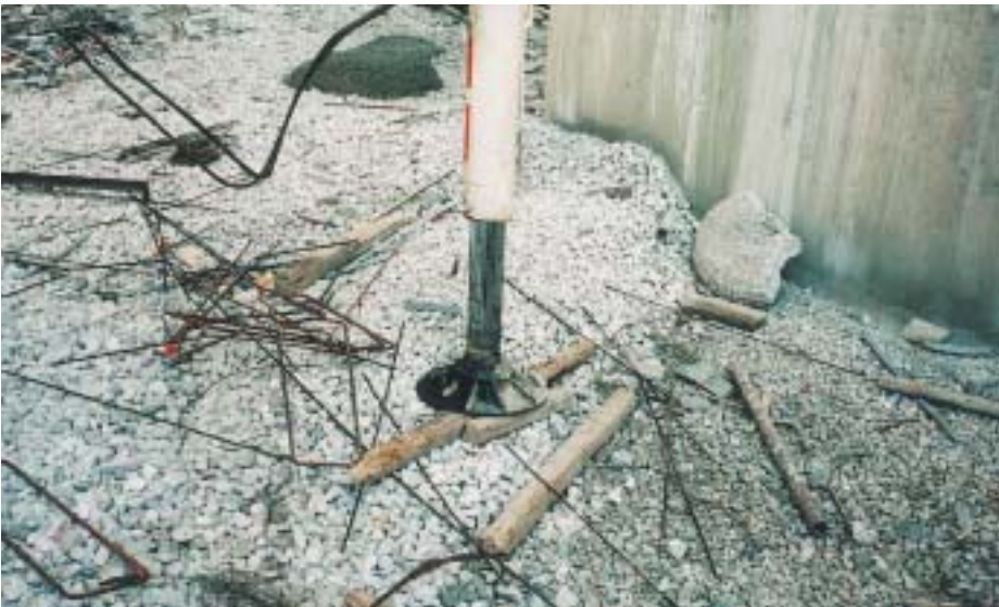
▲ Λανθασμένη έδραση ποδαρικού. Κίνδυνος ανατροπής της αντλίας. Απαιτείται έδραση σε τάκους, αφού καθαριστεί το έδαφος από τα χαλίκια. >
