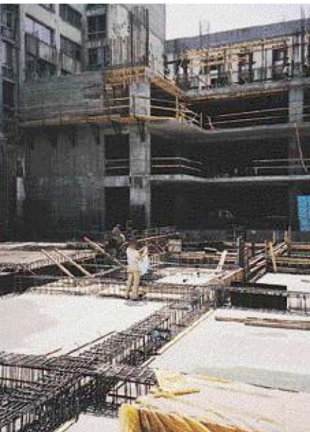
Καλή προστασία στα πέρατα των πλάκων.
