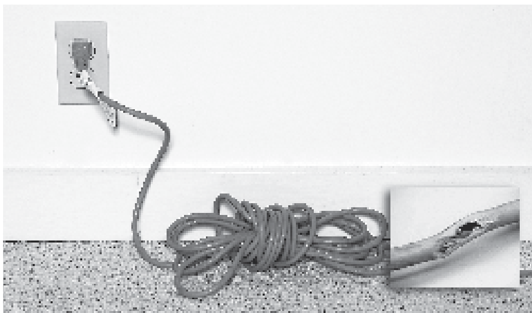
Αυτή η μπαλαντέζα έχει φθαρμένη μόνωση και δεν θα έπρεπε να χρησιμοποιείται.
