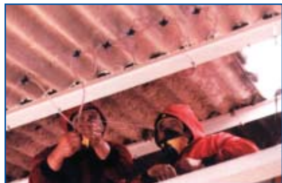
Ελεγχόμενη υγρή αφαίρεση με έκχυση
