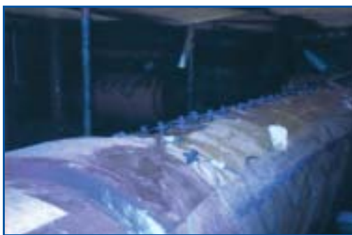
Ελεγχόμενη υγρή αφαίρεση με έκχυση
