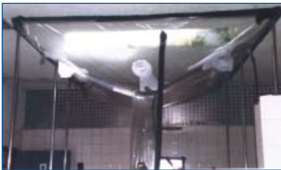
Σάκος με γάντια, σχεδιασμένος για την αφαίρεση επικάλυψης με ψεκασμένο αμιάντο
