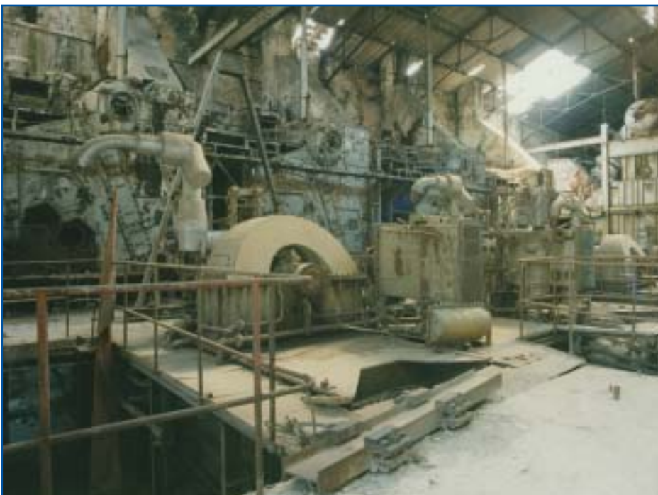
Εργοστασιακοί χώροι με εμφανή παρουσία αμιαντούχων υλικών
