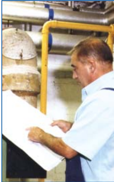
Έρευνα για ύπαρξη αμιαντούχων υλικών σε κτίριο
