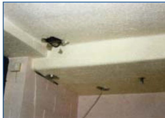
Ένα ταβάνι ψεκασμένο με χρυσότιλο αμίαντο (και συνδετικό τσιμέντο) για διακοσμητικούς λόγους και πυροπροστασία, με σημάδια προηγούμενης φθοράς και επισκευής
