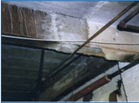
Ψεκασμένος αμοσίτης για πυροπροστασία μεταλλικής στέγης
