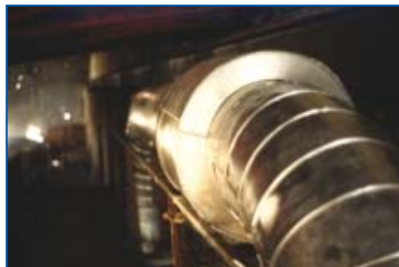
Εγκλεισμός σωληνώσεων που φέρουν μόνωση από αμίαντο
