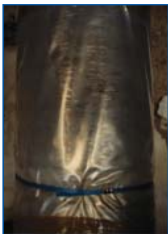
Εγκλεισμός σωληνώσεων που φέρουν μόνωση από αμίαντο
